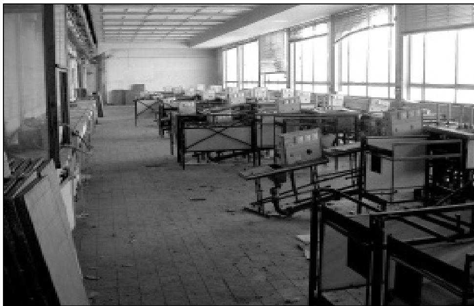
Demontage alter Labore im Zuge der Abbrucharbeiten
